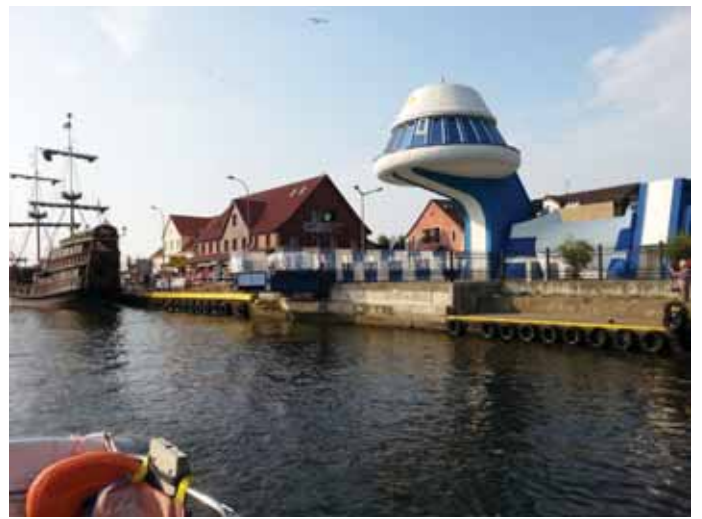
Die Schiebebrücke erreichen wir gerade
