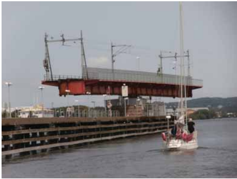
Die 1. Drehbrücke unserer Reise
